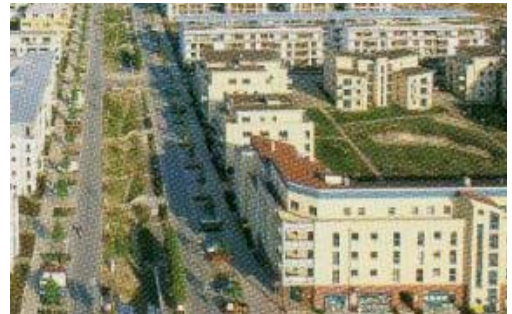
EXPO-Bebauung Hannover-Kronsberg 1998 Qualitätssicherung Block M5 durch NEI Detmold 50 % CO 2 -Einsparung (NEH + Fernwärme)
