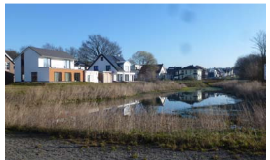
Passivhaus-Siedlung Osnabrück-Gartlage 2012-2014, 23 EFH und MFH, Qualitätssicherung durch NEI Detmold 80 % CO 2 -Einsparung (PH)
