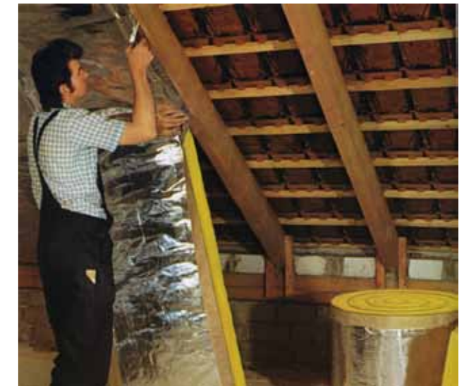
Abb. 3 Die ALU-Randleistenmatte für die Zwischensparrendämmung ist leicht verarbeitbar und bringt größere Dämmdicken nach der Energiekrise.
