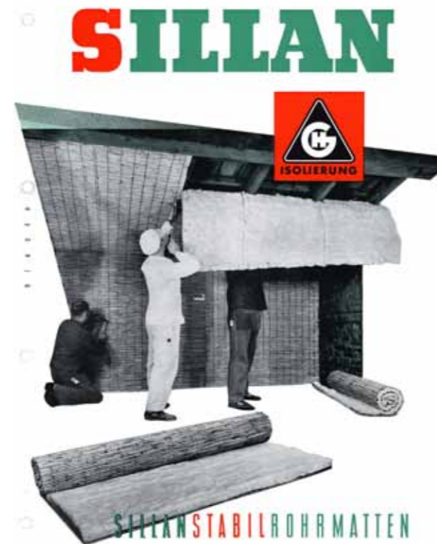
Abb. 12 Glaswolle-Dachdämmung als Putzträgermatte
