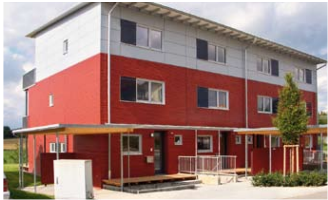
oben rechts: Reihenhaus in Aachen, Baujahr 2002, Wohnfläche pro Einheit ca. 152 m 2 , Wohnfläche: 760 m 2 für 5 Einheiten, Mischbau, Gas-Brennwertkessel zur Deckung des Rest-Heiz- wärmebedarfs, Solaranlage zur Warmwas- serbereitung und geringfügi- gen Heizungsunterstützung.
