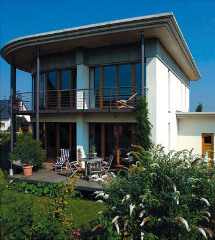
oben: Passivhaus in Ottbergen, Massivbau mit Stahl, Holz und Glas, Baujahr: 1999, Wohnfläche 249 m 2 , Restheizwärmebedarf: elekt. Heizregister 2,1 KW; Fußbodenheizung Bad 2,0 KW. Eine automatische Steuerung regelt die Verschattung, die Lüftung und die Kühlung über einen Erdwärmetauscher.
