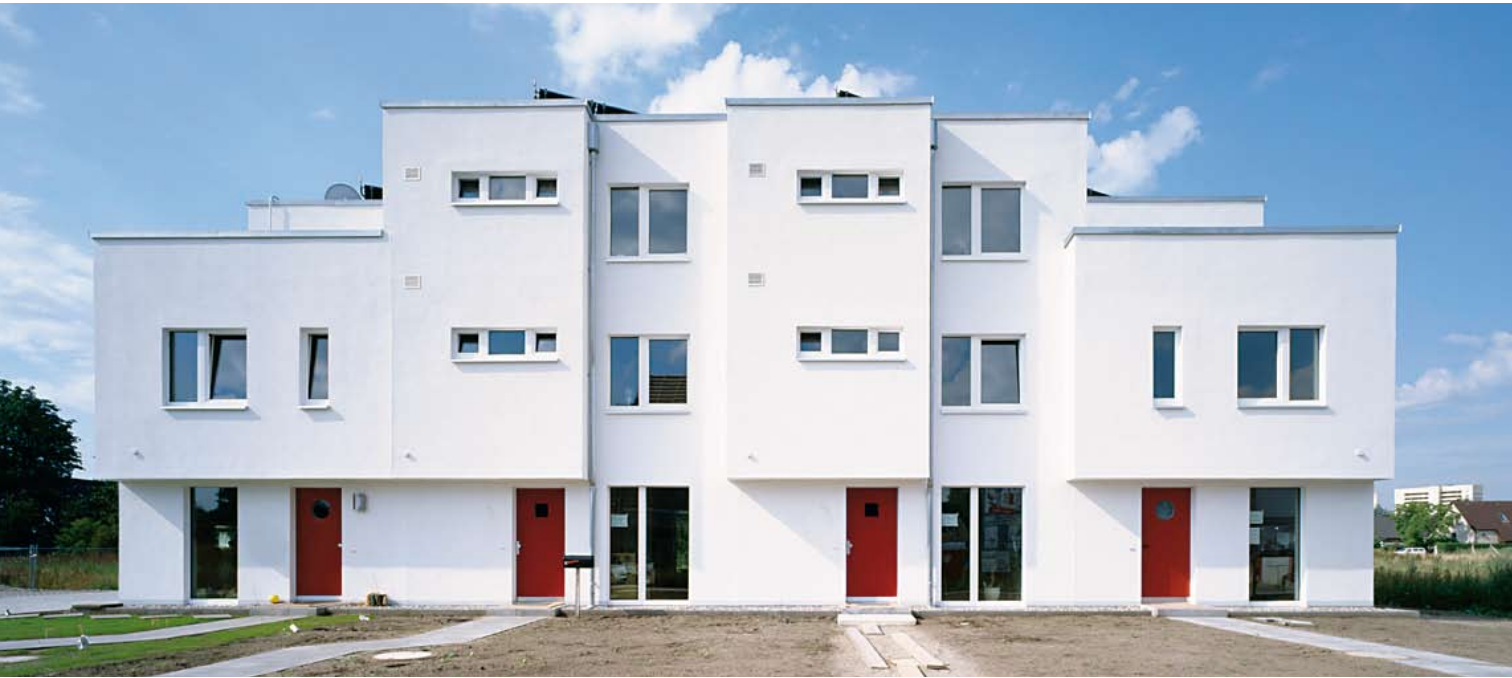
Nordseite, Zugänge zu den vier Reihenhäusern
