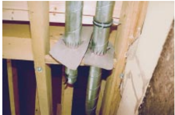
Bild 6.5- 22: Schon bei der Rohrmontage aufgesteckte Manschetten können die Luftdichtung erleichtern.
