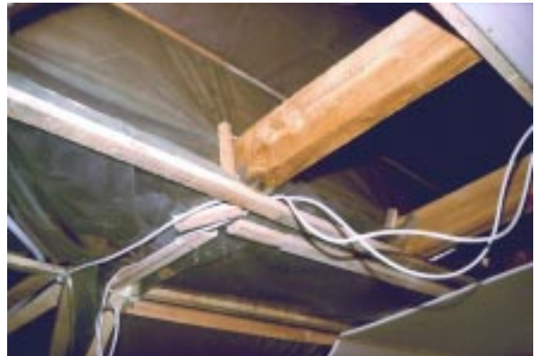
Bild 6.5- 7: Strom-Hüllrohre innenseitig der luftdichtenden Folie ergeben hohe Luftdichtheit.
