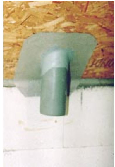
Bild 6.5- 16: Abdichtungs-Manchette einer Abluftleitung nach der Verklebung auf der Spanplatte.
