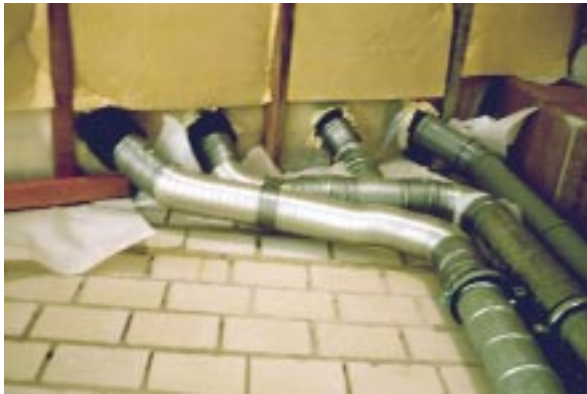
Bild 6.5- 21: Aluflex-Leitungen und Kunststoff-Wellrohre lassen sich praktisch nicht dicht mit Folienebenen verbinden. Montage der Rohre vor dem Verputzen behindert zudem den luftdichten Innenputz.
