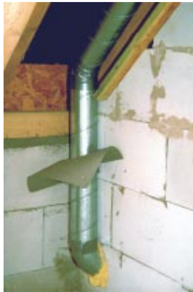
Bild 6.5- 15: Abdichtungs-Manchette auf Abluftleitung schon vom Rohrbauer aufgesteckt. Rohrverlegung in Raumecke behindert jedoch Innenputz und Folienschluß an Wände.
