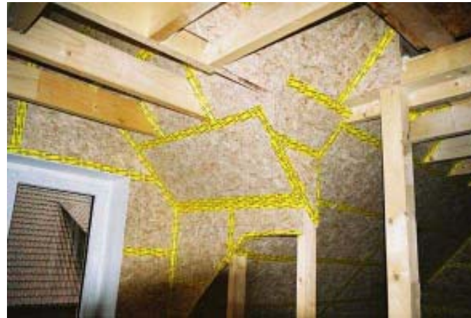
Abklebung durchdringender Holzbalken
