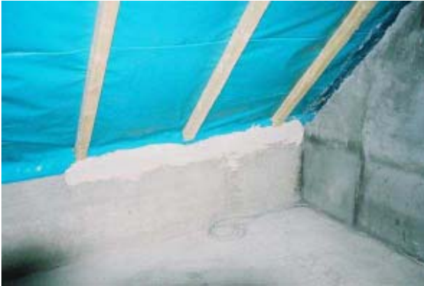
Folie an beton-Drempel
