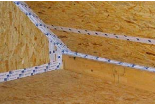
Abklebung aller Fugen
