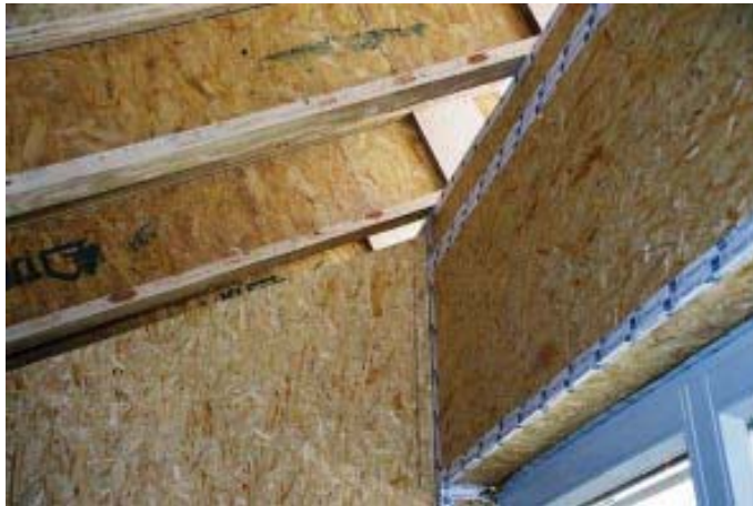
Anschluss OK Innenwand / Dach
